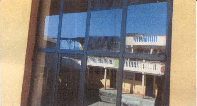
Foto 3: Sustitución de vidrios de ventanas, módulo 1
