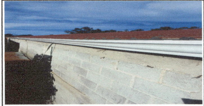
Foto 4: Sustitución de Canal de pvc, módulo 1
