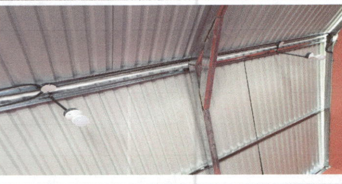
Foto 5: Sustitución de Plafoneras, módulo 1
